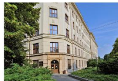
Rekonstrukce budovy B
