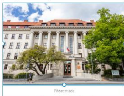
Rekonstrukce budovy A
